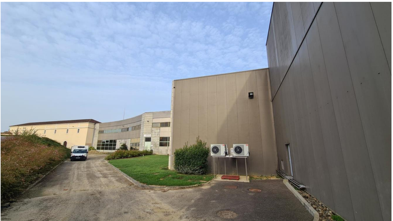
PHOTO 4 : VUE DE LA FACADE EST DE L'ETABLISSEMENT
