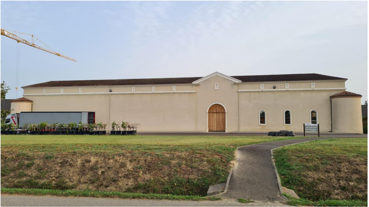
PHOTO 1 : VUE DE LA FACADE SUD-EST DE L'ETABLISSEMENT
