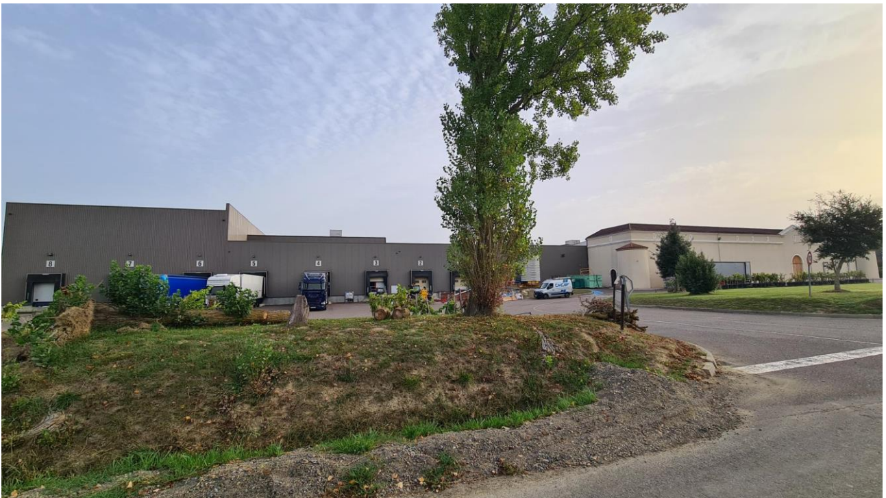
PHOTO 2 : VUE DE LA FACADE SUD-OUEST DE L'ETABLISSEMENT
